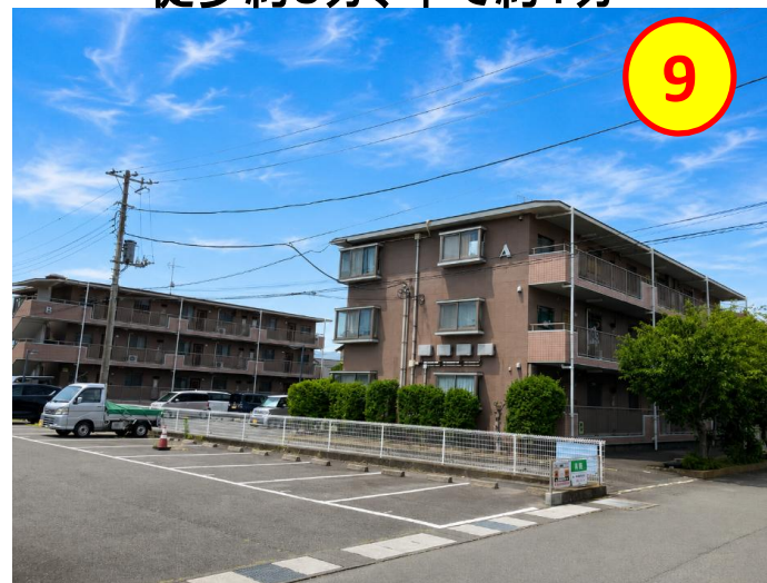
津波避難ビル『榎ノ口ハイツ A棟、B棟』 徒歩約4分
